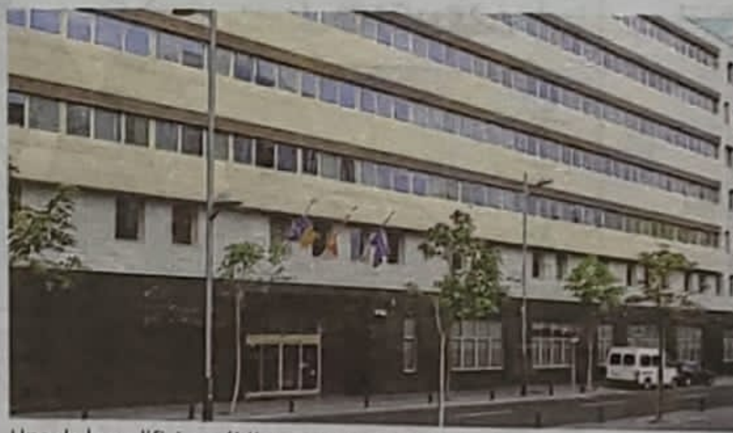
Uno de los edificios públicos que será rehabilitado. C7
